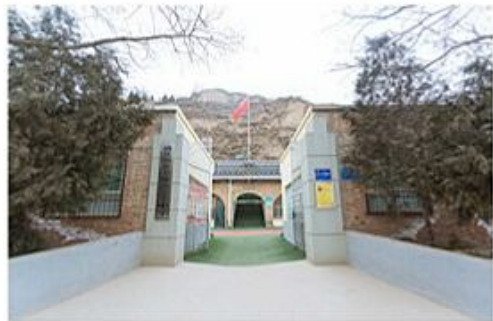
▲授德县满堂川镇土地岔小学旧教学楼，因年久失修，窑洞内出现裂缝，又地处山体滑坡隐患点，学校被市级认定为危房，直至今日，仍没有得到有效解决，学生的安全得不到保障。
